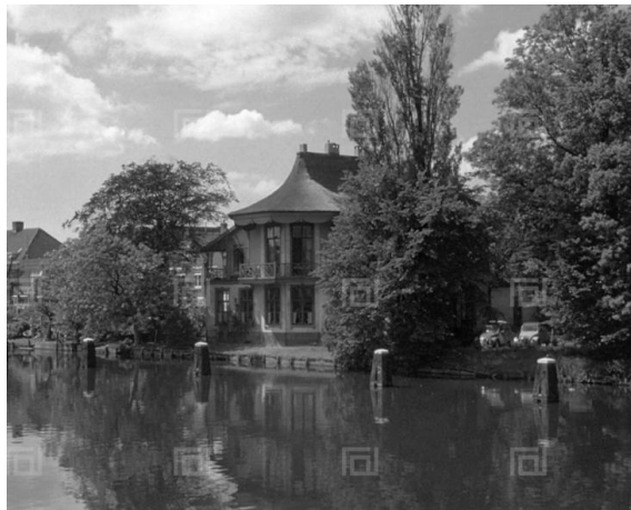
Afb. 64 – Gezicht op de villa Bloemlust gezien vanaf het Galgewater (1962).
